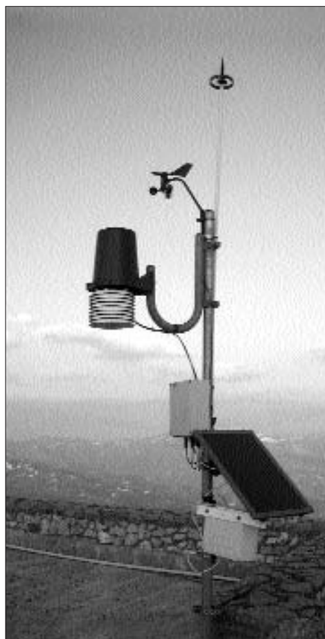
Figura 1 - La centralina meteo posta sulla terrazza della Rocca
